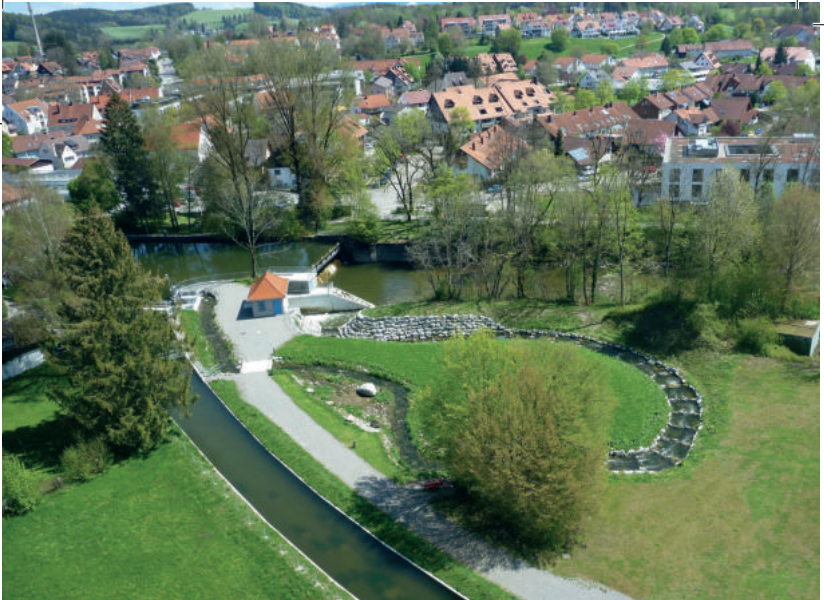
Fischaufstiegshilfe und Mindestwasserkraftwerk T 8a der Stadtwerke Wangen im Allgäu
